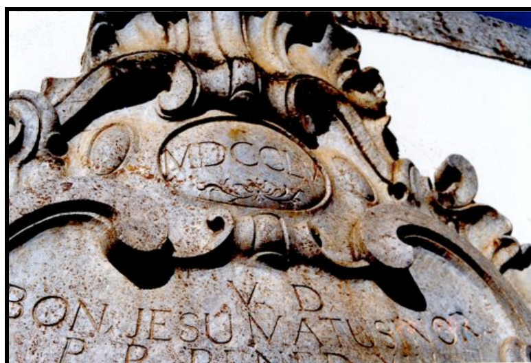
Frontão de pedra sabão da matriz de Congonhas do Campo, atacado pelo pó de minério e pelo fungo ferruginoso foto Oswaldo Sevá julho de 2001
