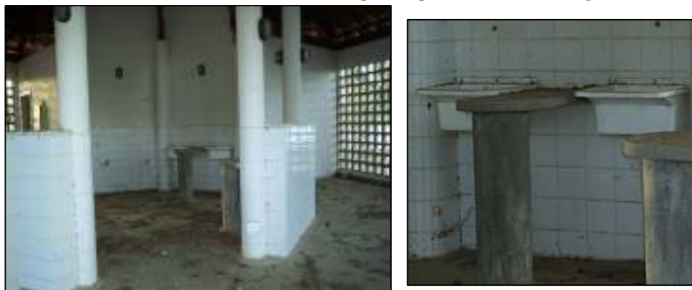
FOTOS 5 e 6: Lavanderia construída pela Itapebi Geração de Energia S/A
