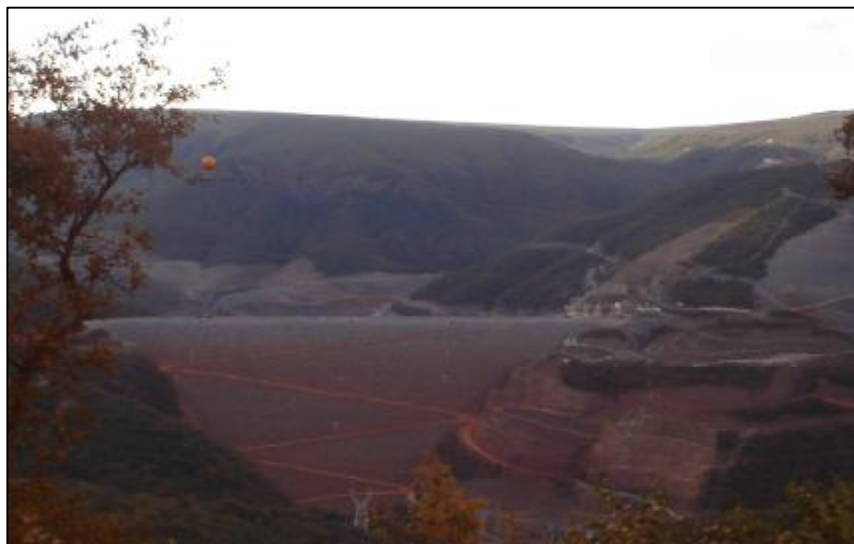
FOTO 1: Eixo da UHE Irapé (em construção) - Julho/2005
