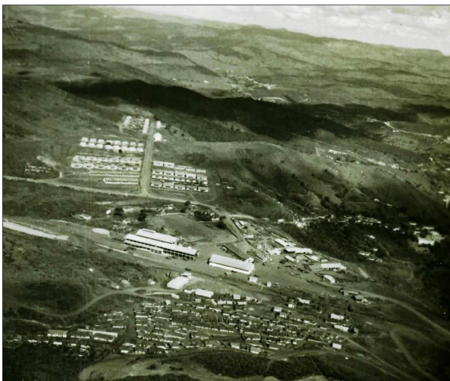
Figura 16: À frente a Vila Sagrado Coração de Jesus (Explosivo), ao centro os pavilhões da sede da Vale, atrás deles, a Vila Santana e ao fundo o bairro Campestre. No declive à direita a primeira Itabira e no horizonte as áreas povoadas nas décadas de 1970 e 1980
