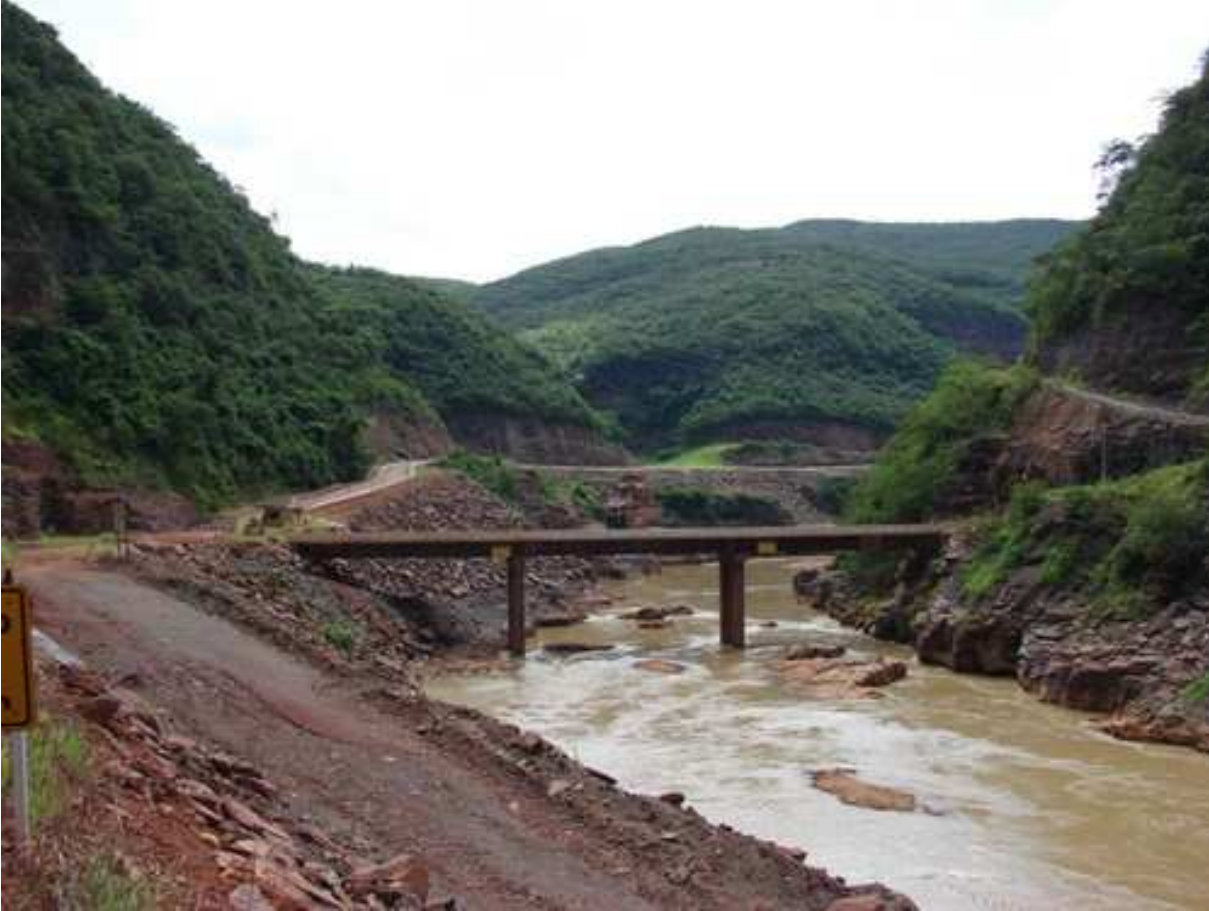
Trecho entre casa de força e ponto do desemboque do sistema vertente submersa
