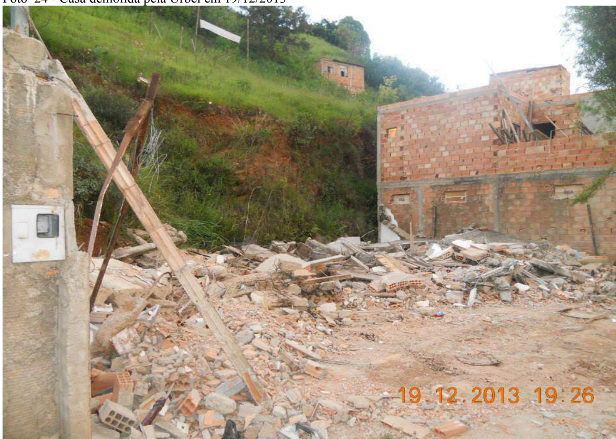
Foto 24 - Casa demolida pela Urbel em 19/12/2013
