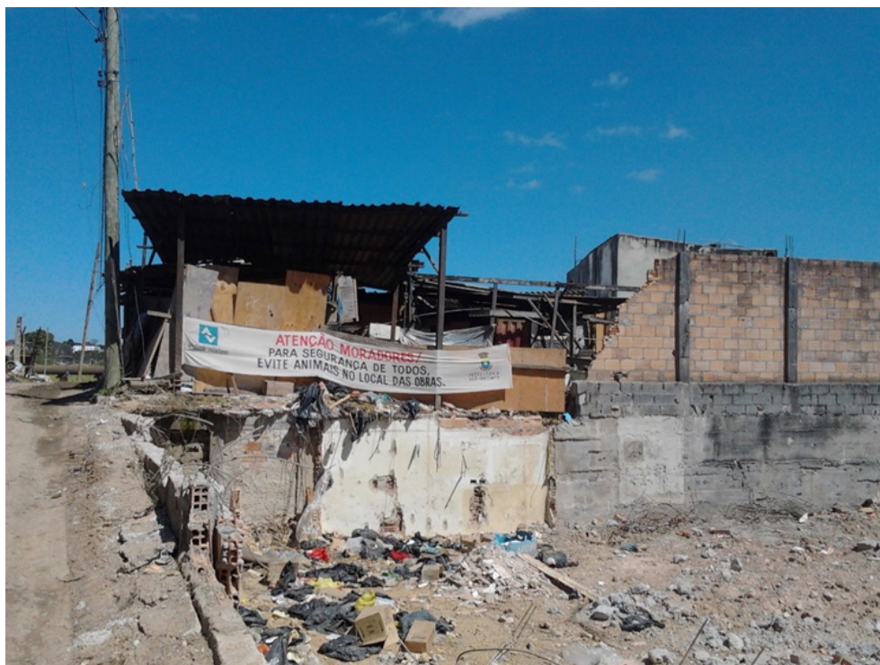
Figura 01 Aviso da URBEL para o afastamento dos animais dos locais das obras. A faixa está pregada nas próprias baias dos carroceiros. Fonte: Autor, 2012.
